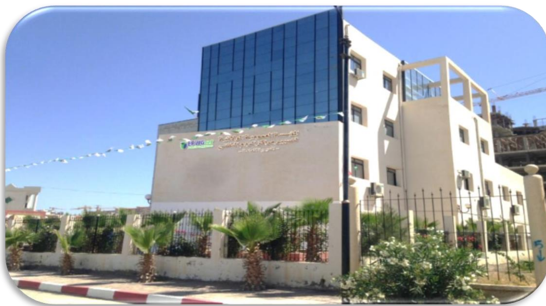
Figure 02 : Siège de l'administration de l'EPWGCET.
