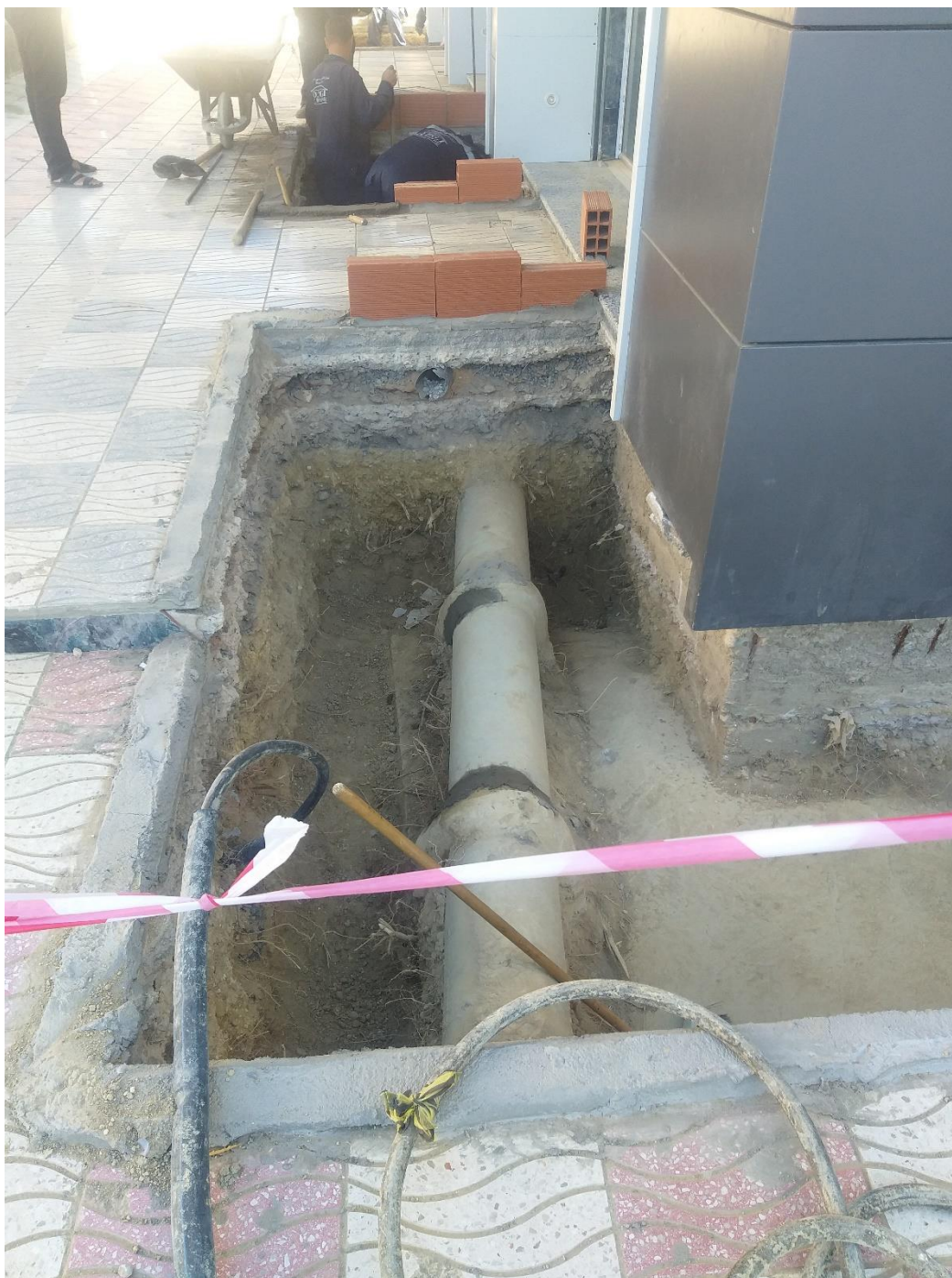
Figure II.2 : Intervention et réparation du système d'eau pluviale au pied de l'ouvrage.
