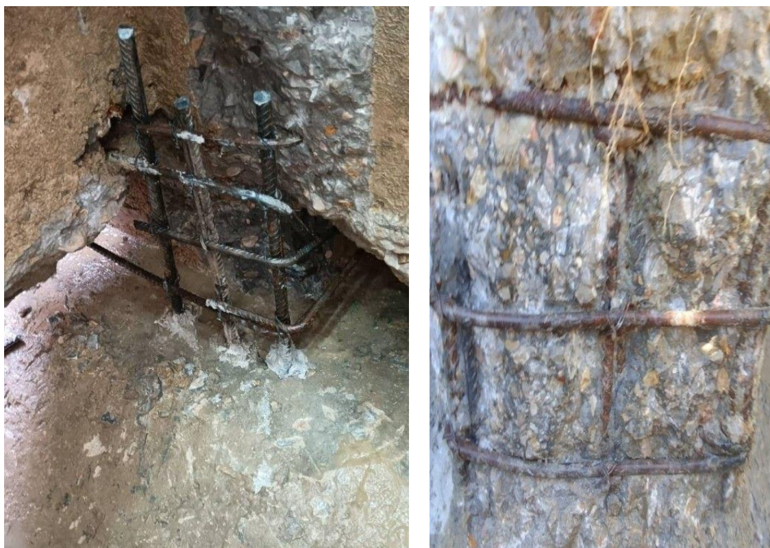
Figure III.2 : reprise et chemisage en sous oeuvre.
