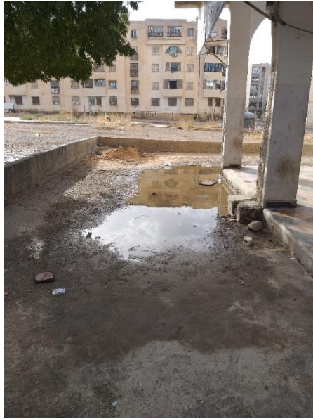
Figure II.3 : Accumulation des eaux pluviales du côté est du bâtiment.
