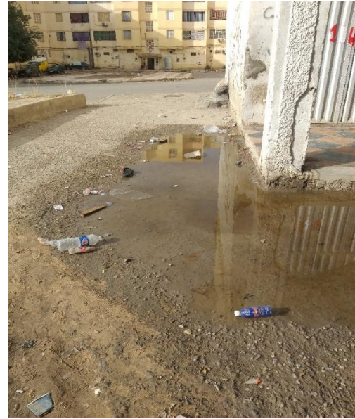
Figure II.3 : Accumulation des eaux pluviales du côté est du bâtiment.
