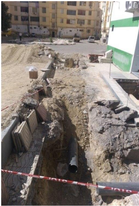
Figure III.1: Reprise des réseaux d'assainissement et d'AEP.
