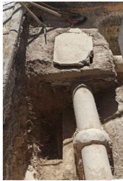
Figure III.1: Reprise des réseaux d'assainissement et d'AEP.
