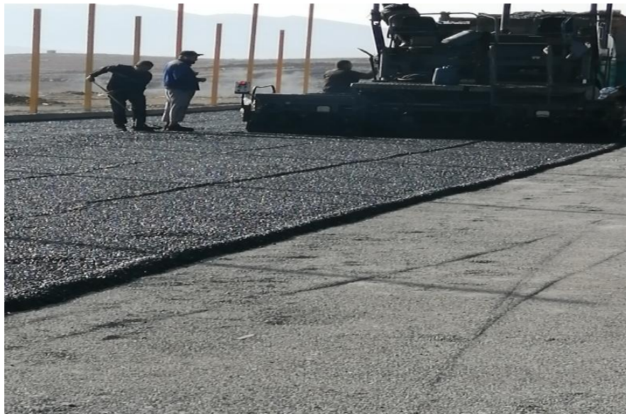
Photo.II.4. bande d'essais en béton bitumineux modifié
