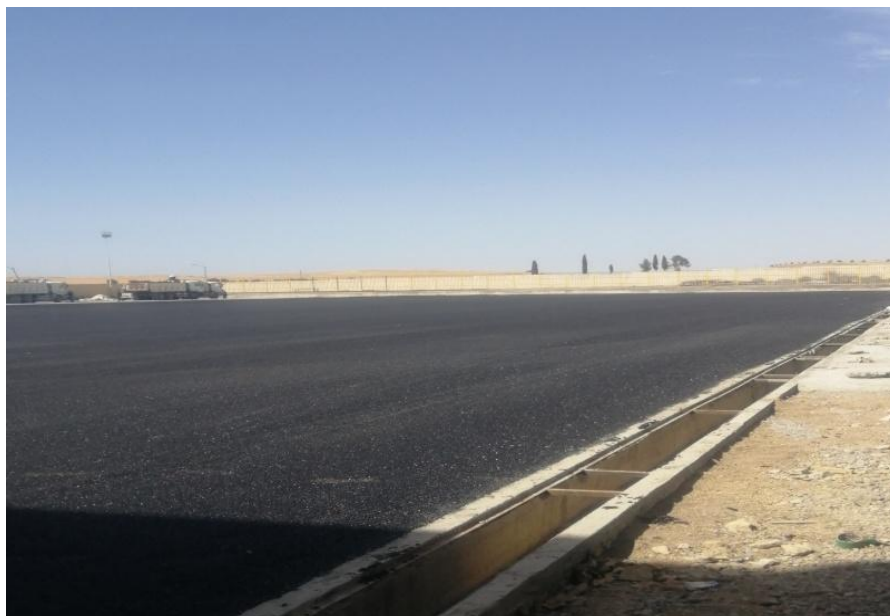
Photo.II.5. Un terrian sportif de proximité ( TSP) réalisé en béton bitumineux modifié
