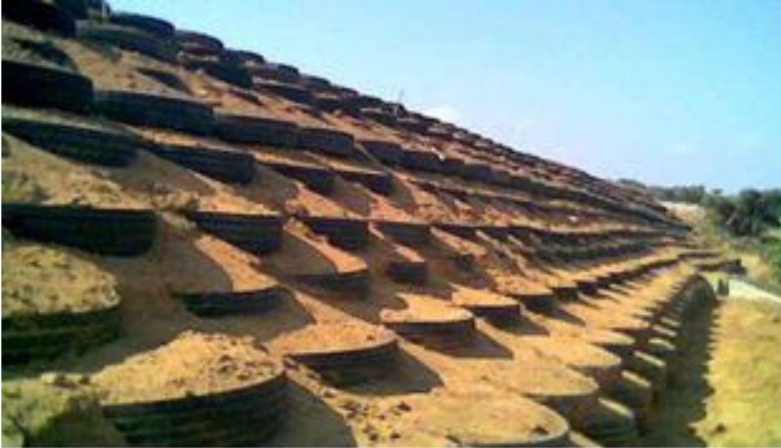
Figure I.5 : Chantier expérimental Pneu sol à Bou-Ismaïl [3].
