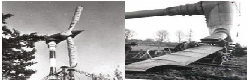
Fig.I.11: Eolienne de 100kW [26]
