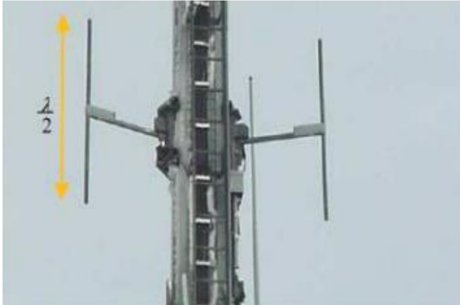
Figure 6 : Dipôles verticaux d'un émetteur FM
