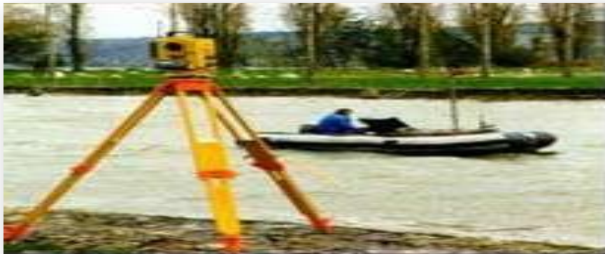
Figure I.12: Estimation de l'envasement par la méthode de nivellement
