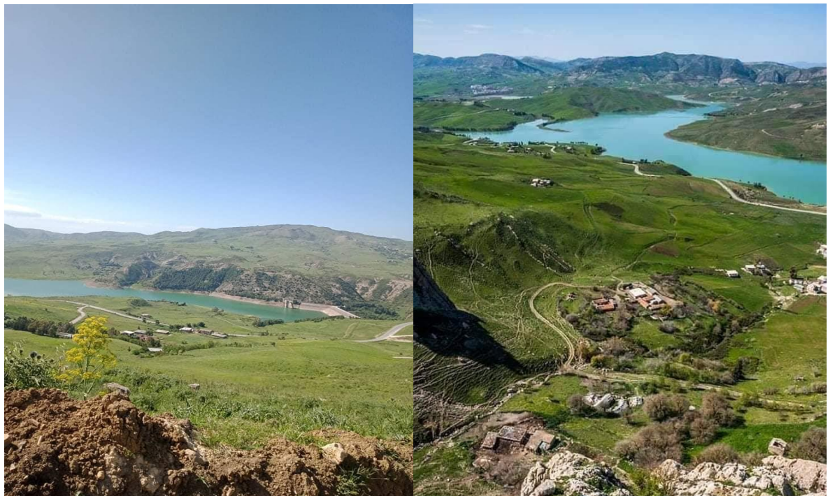
Figure III.2 : Vue du barrage d'Ain Dalia.
