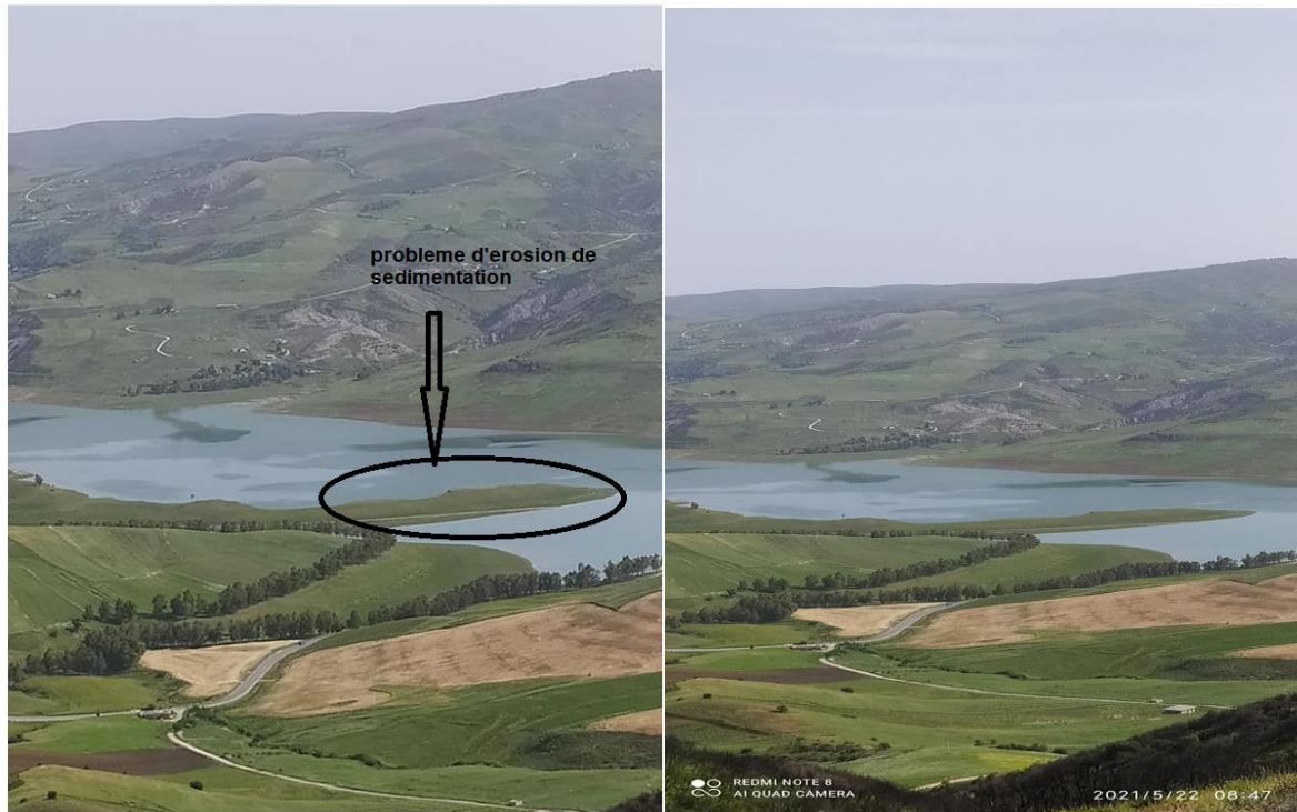
Figure III.3 : Problème d'érosion de sédimentation du barrage d'Ain Dalia
