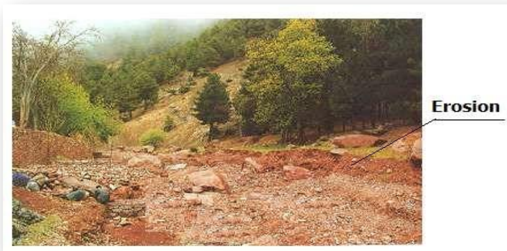
Figure I.7: Dégradation d'un lit d'oued.
