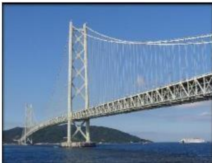
Figure I.14 : Le pont Akashi Kaikyo. [88]
