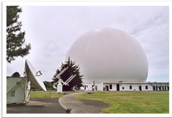
Figure I.3 Centre de télécommunication par satellite PLEUMEUR_BODOU
