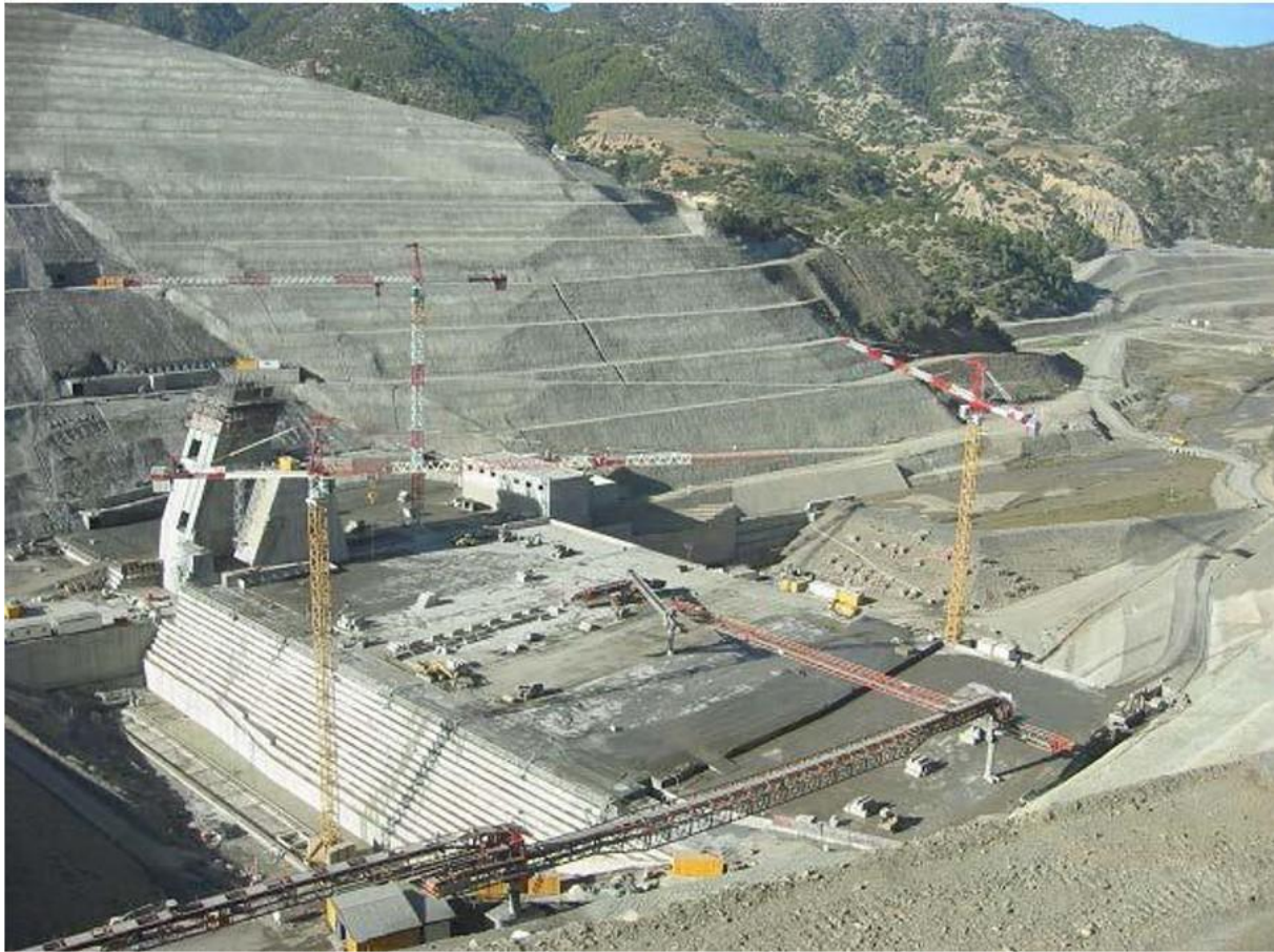
Figure 1. 1 : Barrage de Koudiat-Acerdoune en Algérie pendant la construction (Forbes2007).
