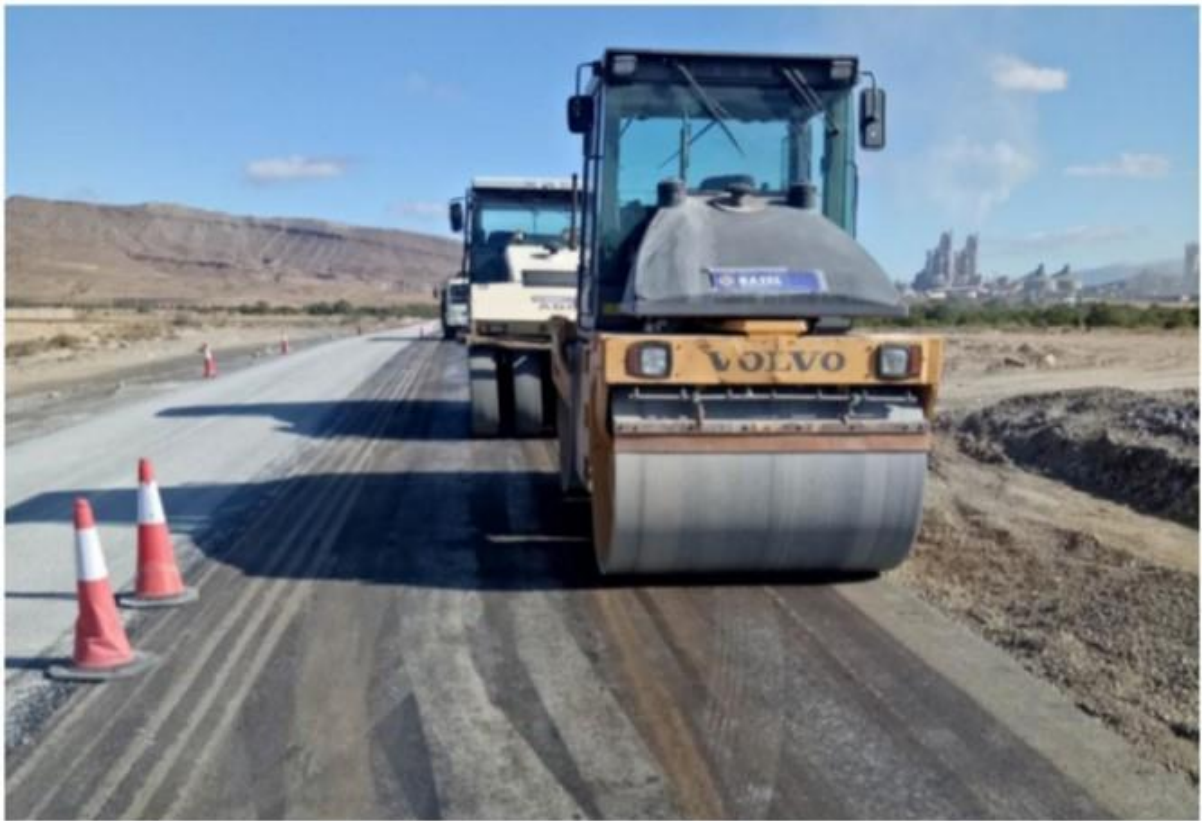
Figure 1. 2 : Mise en place d'un BCR routier (route HAMMAM DALAA).
