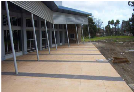
Figure I. 1 Pavé de géopolymère en Australie ( www.zeobond.com ).
