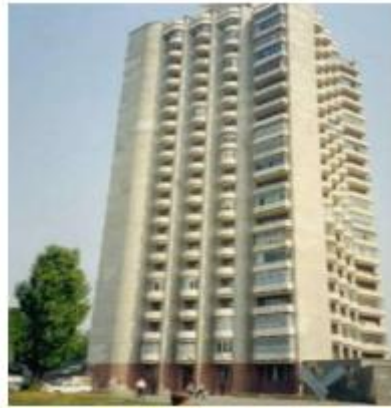
Figure I. 5 Premier immeuble en béton géopolymère à Lipetsk, Russie, 1994 (Boumediene, 2022).
