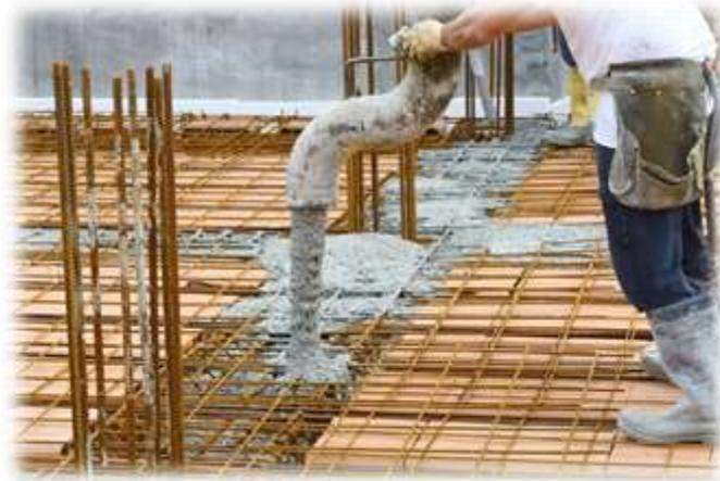
Figure 2 : Le béton auto plaçant.
