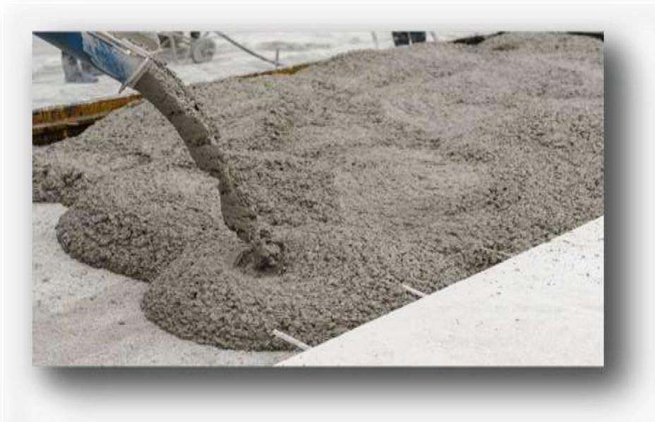
**Figure 1:** Béton ordinaire.
