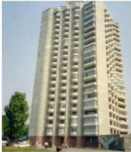
Figure 1. 4 Premier immeuble en béton géopolymère à Lipetsk, Russie, 1994 (Boumediene, 2022).
