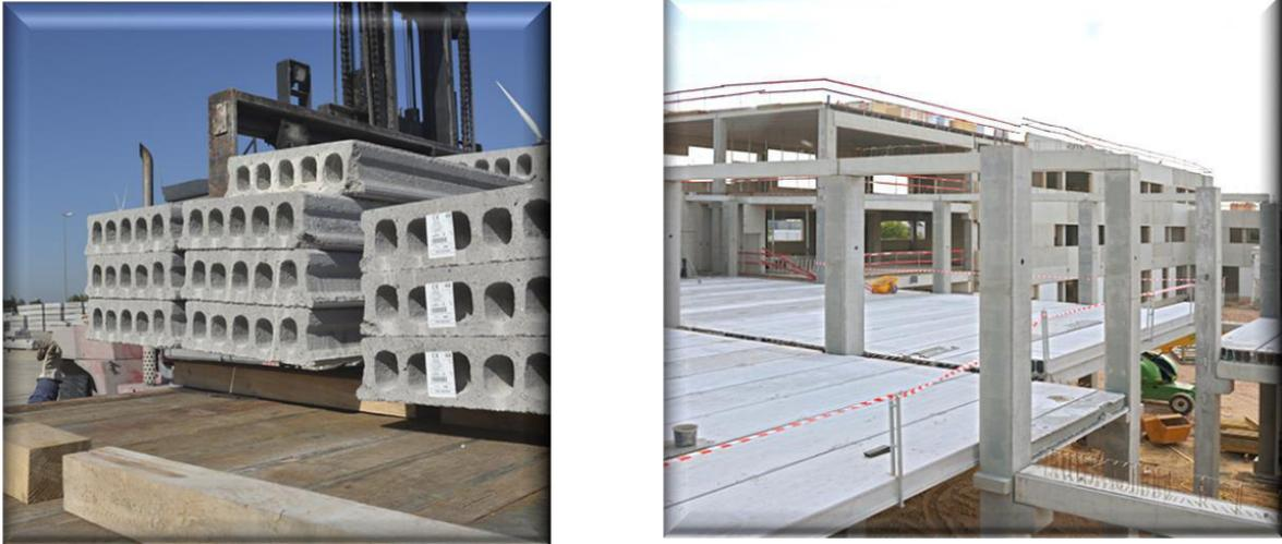
Figure II.9 : l'élément de plancher en béton précontraint.
