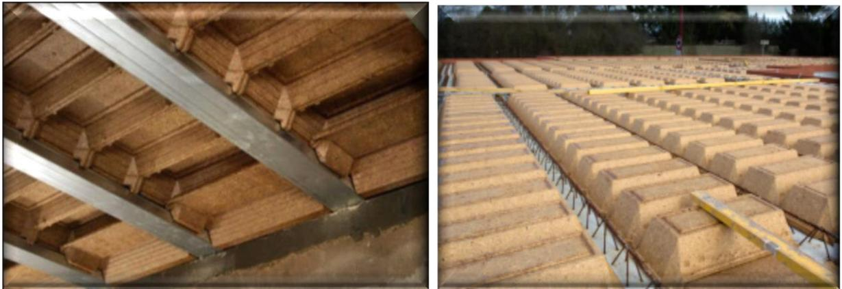
Figure II.10 : Plancher par hourdis en bois.
