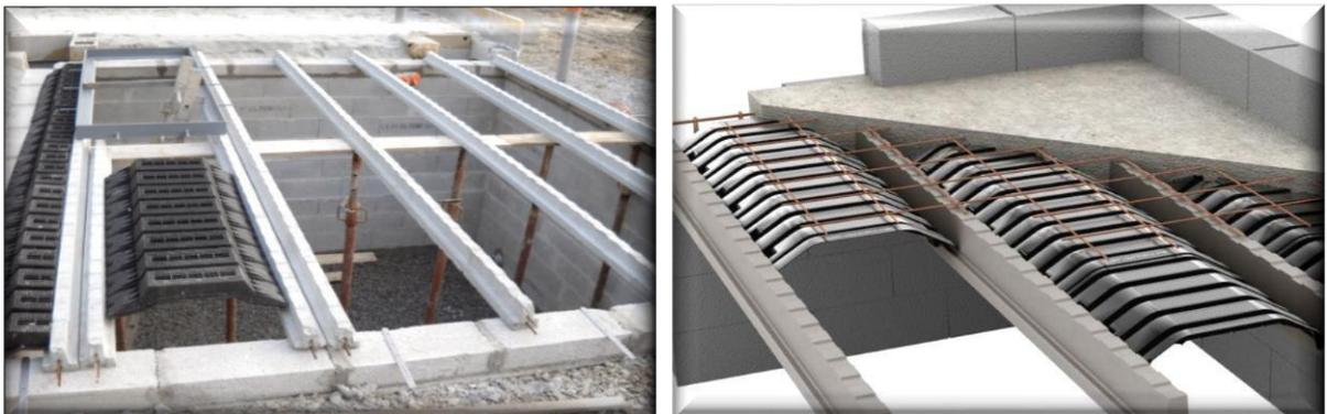
Figure II.11 : Emplacement hourdis plastique sur les poutrelles.
