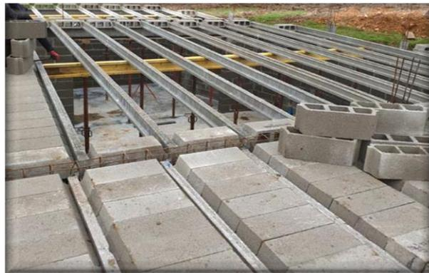
Figure II.3. Hourdis béton.
