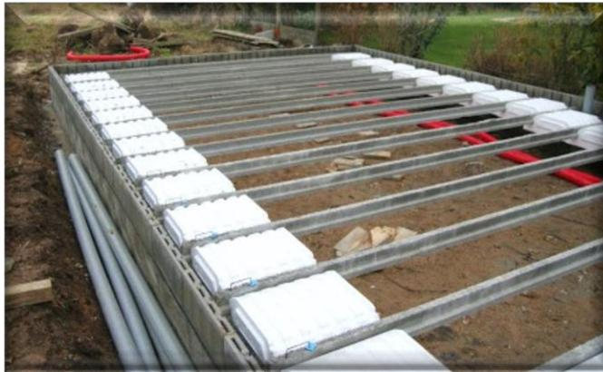
Figure II.7 : Plancher de l'hourdis polystyrène.
