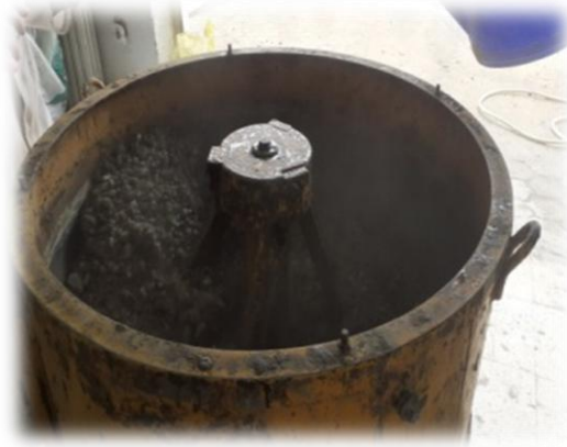
Figure 2. 4 Coulage les poutres en BHP.
