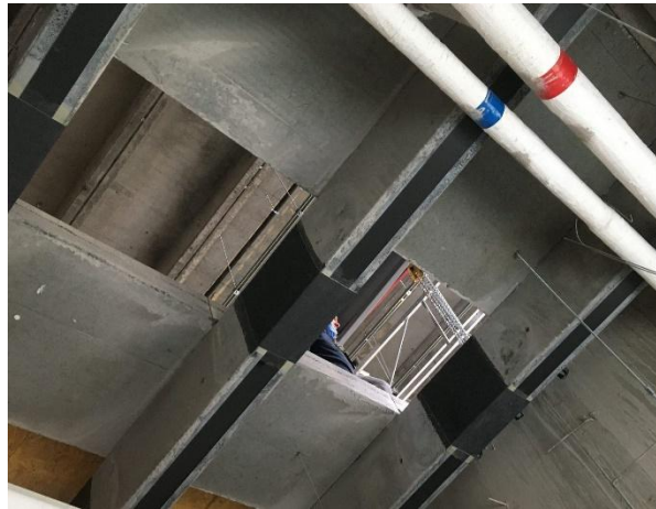
Figure 1. 1 Poutre en béton armé renforcée (site web).
