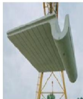
application du BAP dans la préfabrication
