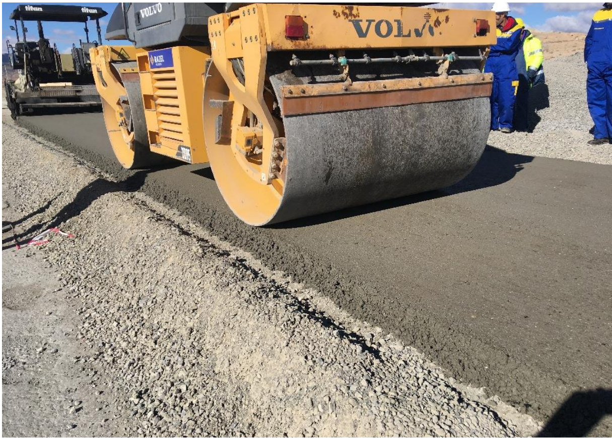
Figure 1. 1 : mise en place d'un BCR routier
