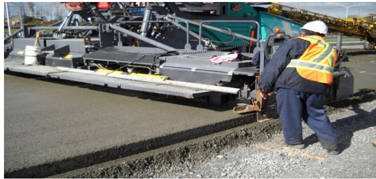
Figure I. 1: Mise en place du BCR en pavage - Atlanta USA (Gauthier. P et al., 2000).
