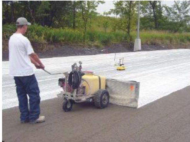
Figure I. 14: Application d'un produit de cure après compactage du BCR - aire Industriel - Montréal (Association Canadienne du ciment).
