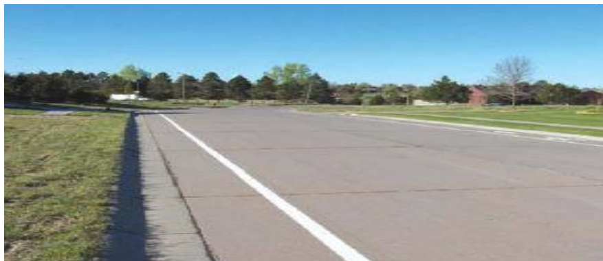
Figure I. 6: Etat d'une chaussée en BCR après 11 ans de service - USA (Gauthier. P et al, 2000).
