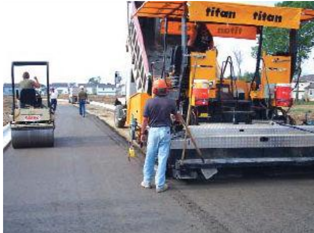
Figure I. 11: Mode de mise en œuvre et de compactages du BCR (Gagné. 2000).
