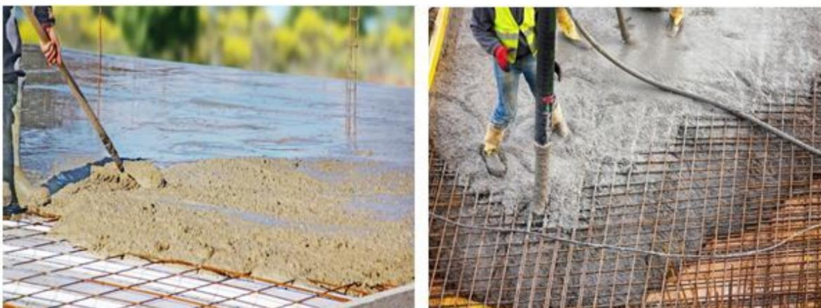
*Figure (1.1) : le béton autoplaçant [1]*
