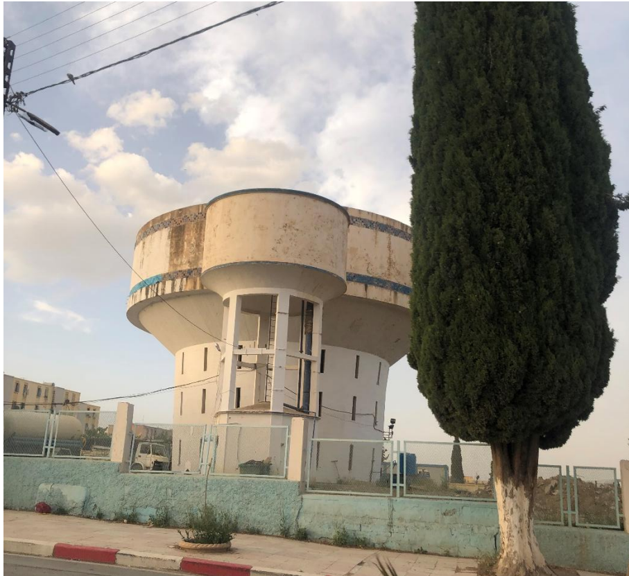
Figure 2- châteaux d'eau, DALAS, BBA.
