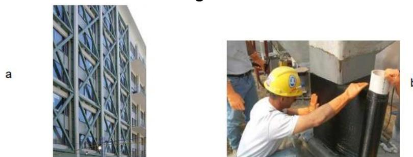
**Figure II.15 :** a) Renforcement par contreventements métalliques extérieurs, b) Renforcement par collage de tissus de fibres de carbone autour d'un poteau en béton armé [Réf : document **LE RISQUE SISMIQUE**].
