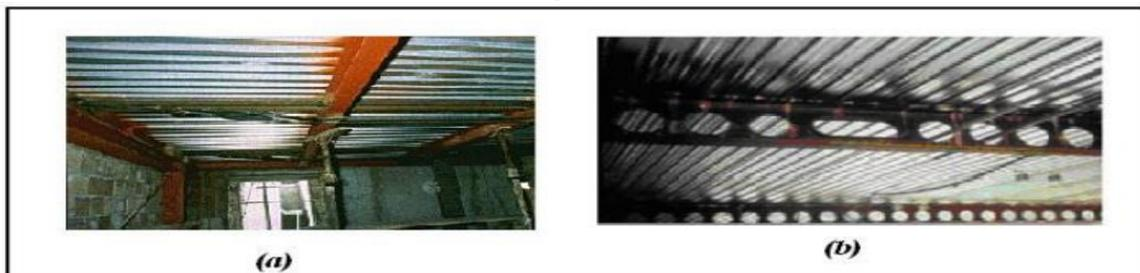
**Figure IV.9 :** Le remplacement des planchers lourds par des planchers métalliques.
