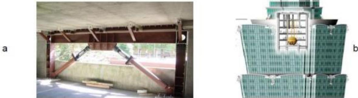
**Figure II.14 :** a) Contreventement amortissant au sein d'une structure en béton (ph. Staleson), b) Masse « accordée » en haut de la tour Taipei 101 (Taiwan) [Réf : document **LE RISQUE SISMIQUE**].
