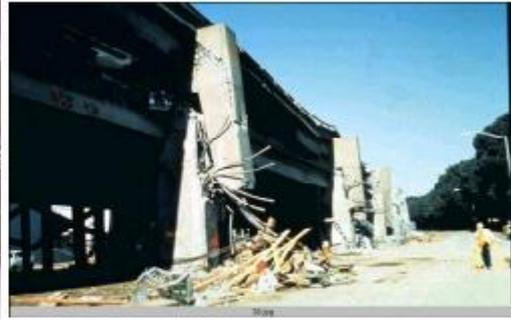
**Figure II.17** : Effondrement de ponts ; à droite, pont construit en pendule inversé (masse sur tige) et à gauche rupture d'un pont du fait de la faiblesse de la liaison entre les 2 tabliers superposés [Réf : document **LE RISQUE SISMIQUE**].
