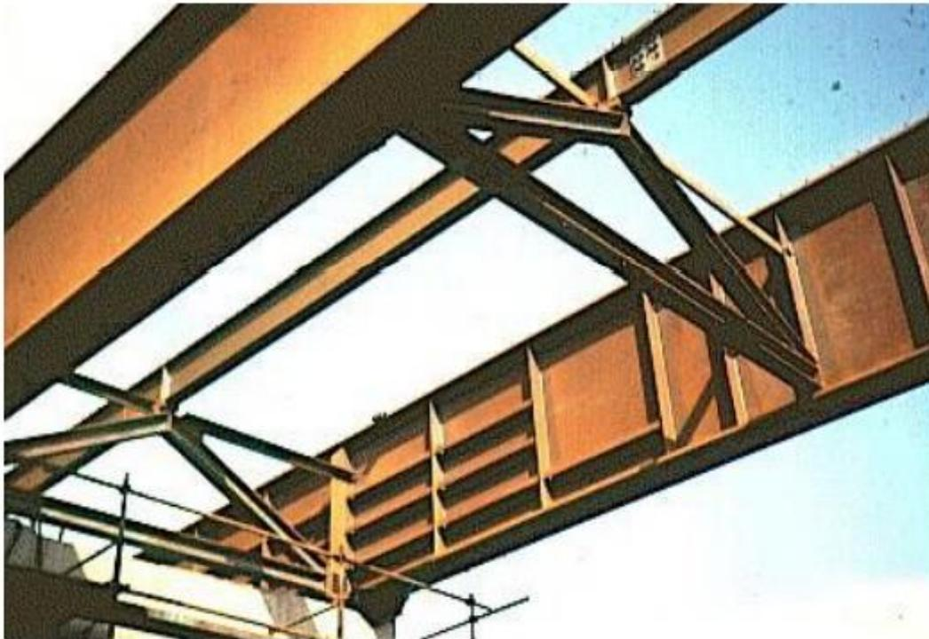
**Figure IV.21** : Le renforcement des éléments par une augmentation des sections.
