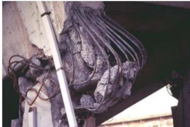
**Figure II.18** : Effondrement de poteaux en béton armé du fait de manque de renforcements ; à gauche, par compression excessive ; à droite par cisaillement de la liaison avec une poutre [Réf : document **LE RISQUE SISMIQUE**].
