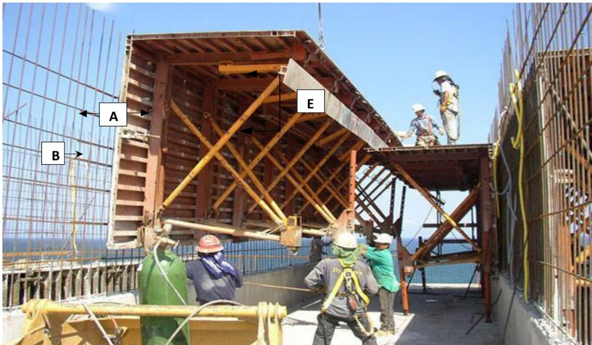
*Figure 3 une demi-coquille sur chantier*
