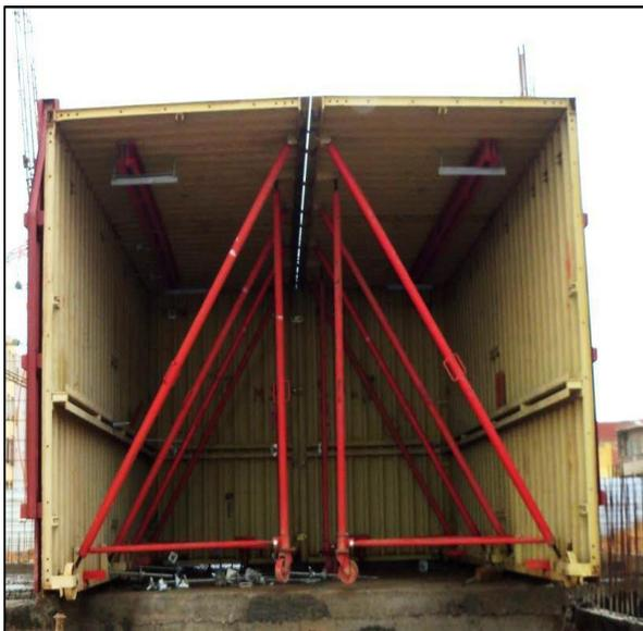
Figure 6 Assemblage de deux demi- coquilles sur chantier
