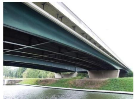
Fig. I.21 : un exemple de pont mixte bipoutre.
