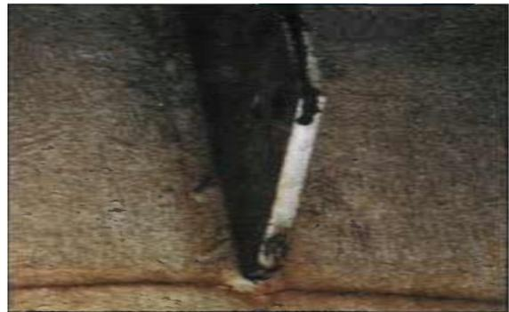
Fig. V.26 : Fissure de fatigue à la base d'un raidisseur vertical.
