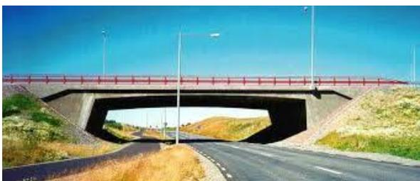
**Fig. I.7 : pont cadre avec un mur en aile.**
