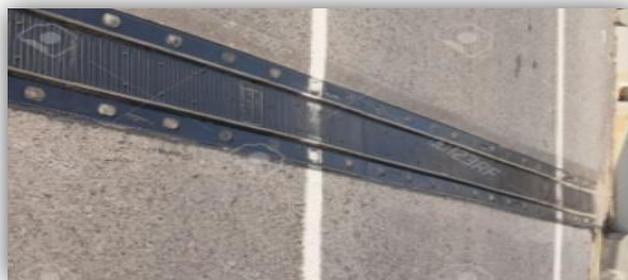
Fig. VI.5 : joint de chaussées.
