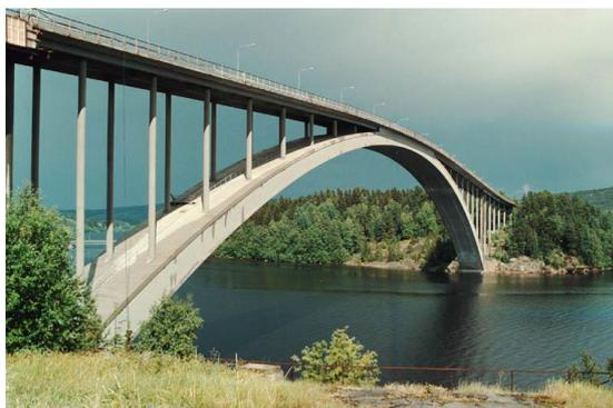
Dans un pont en arc, la rivière ou la brèche est franchie en une seule fois par une seule arche alors que dans le pont à voûtes, le tablier repose sur des piles intermédiaires. Le pont en arc associe la compression à la flexion.
