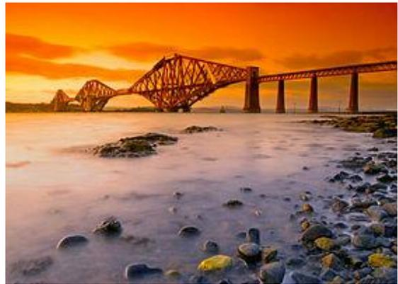
**Fig.I.3 : Pont du Firth of Forth (Écosse), réalisé en 1890, avec deux travées de 521 mètres.**
