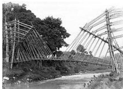
**Fig. I.10 : Pont en bambou avec des haubans en bambous, à Java.**
