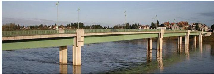
Fig. I.25 : pont à poutrelles enrobées.
