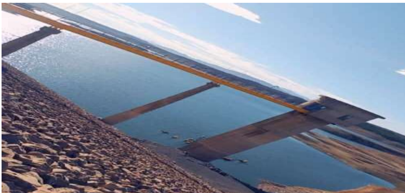
Figure 1 : Le barrage d'AIN ZADA (collection personnelle)
