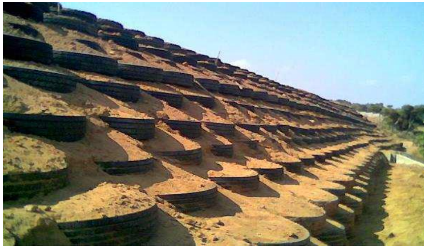
Figure 1.16 : Chantier expérimental Pneu sol à Bou-Ismaïl
