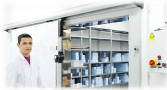
Figure II.9 : Au niveau de la chambre froide. [25]
