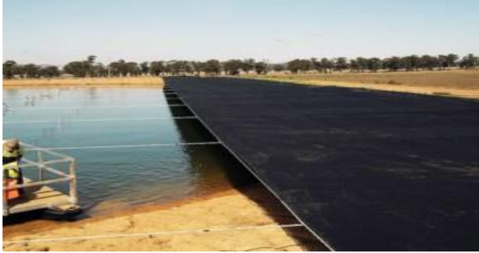
Figure.4- Technique de Toile d'ombrage contre l'effet d'évaporation
