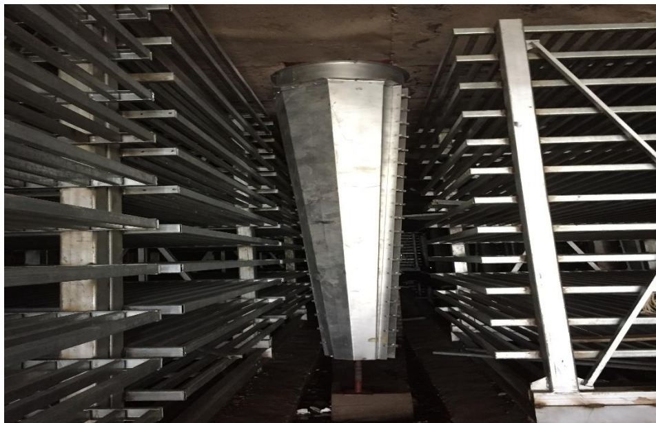
Figure II.5 : Tunnel de séchage pour la brique de brûleur à gaz
