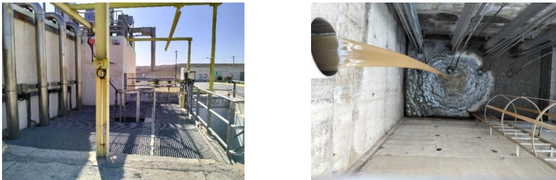
Figure 03 : Bâtiment de relevage
