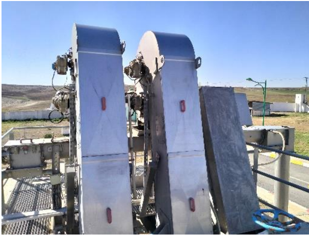
Figure 04 : Grilles mécaniques (Dégrilleur)
