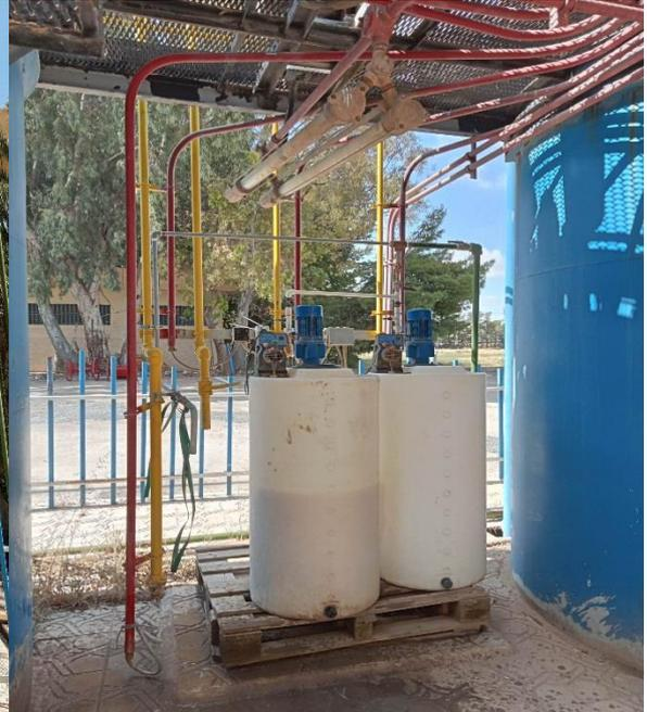
Pompes doseuses du coagulant/floculant
