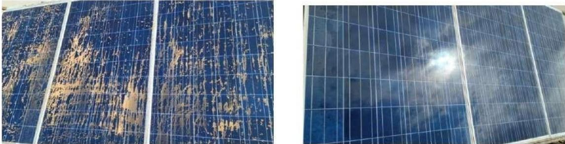
**Figure III. 1 :** Photos des panneaux photovoltaïques avant et après le lavage.
