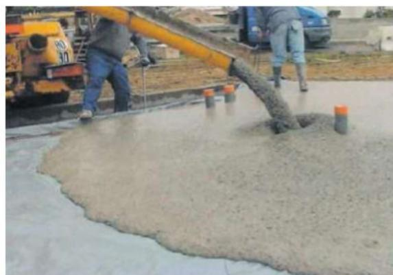
*Figure I.3 Exemple d'un coulage d'une dalle en béton autoplaçant [4]*
