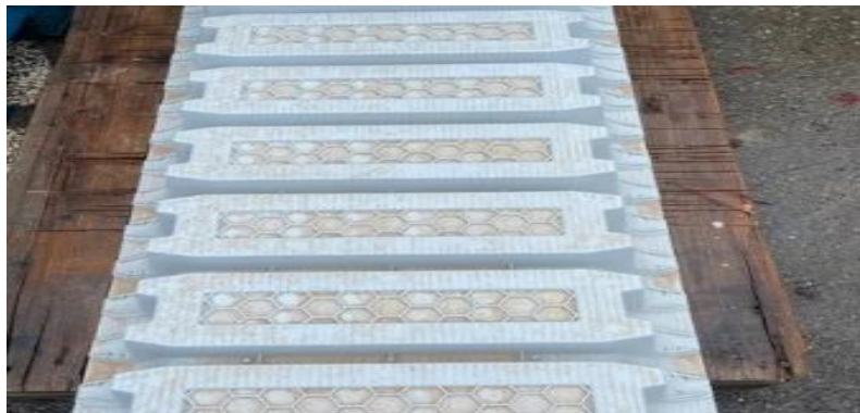
Figure II 5: Pose de hourdis en PVC
