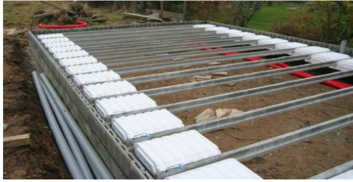
Figure II 4: Pose de hourdis en polystyrène.
