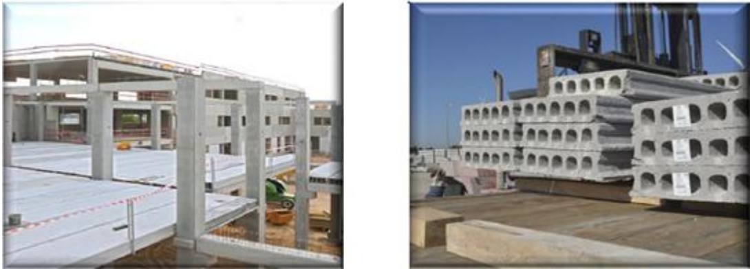
Figure II 8: L'élément de plancher en béton précontraint.
