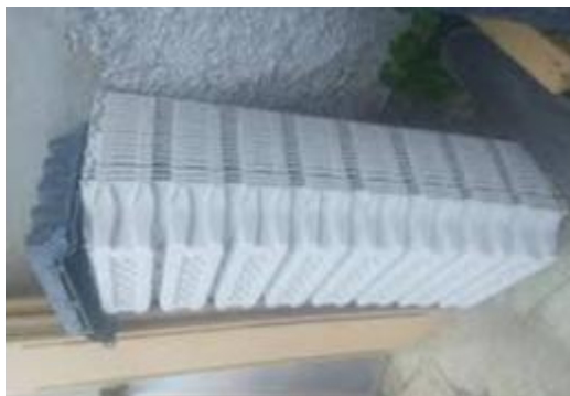
Figure II 9: Emplacement hourdis plastique sur les poutrelles.
