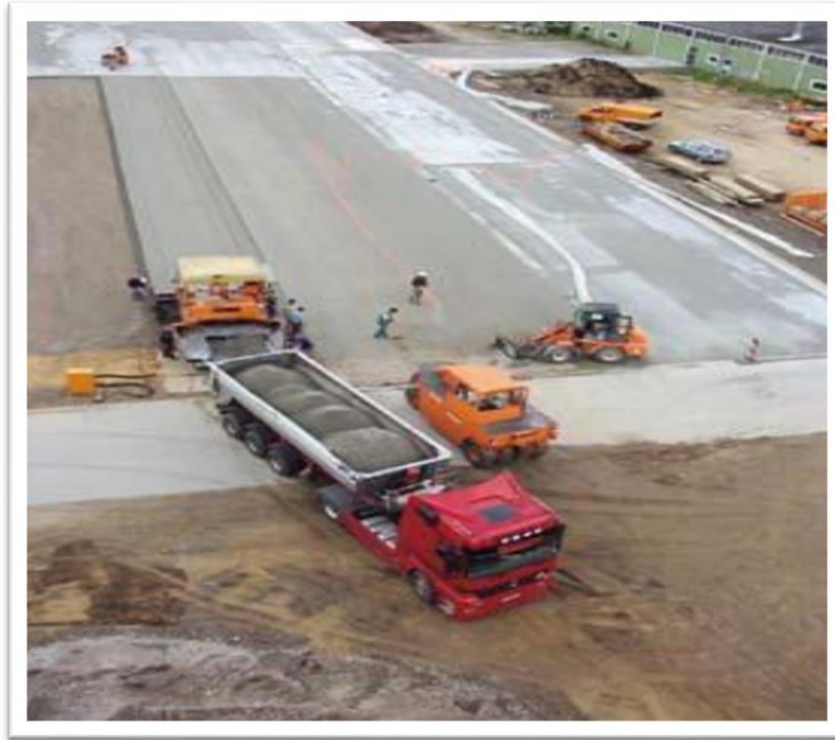
Figure.I.7.Mise en place de BCR par bandes [32].
