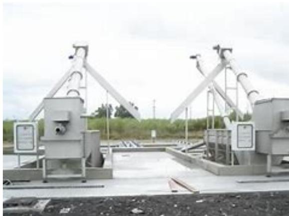
FIGURE 1.17 : Dégrillage, dessablage et déshuilage / dégraissage - definitive ecology
