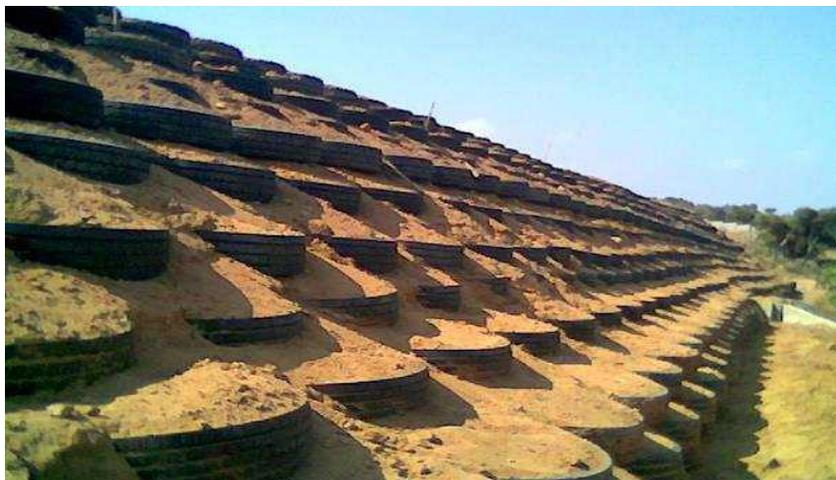
**Figure 1.16 : Chantier expérimental Pneu sol à Bou-Ismaïl****Tableau I.6 : Ouvrages Pneu sol réalisés**
