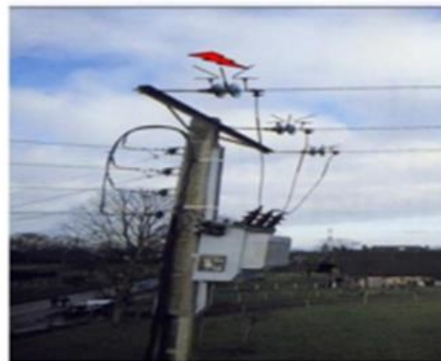
b- Photo réelle d'un éclateur
