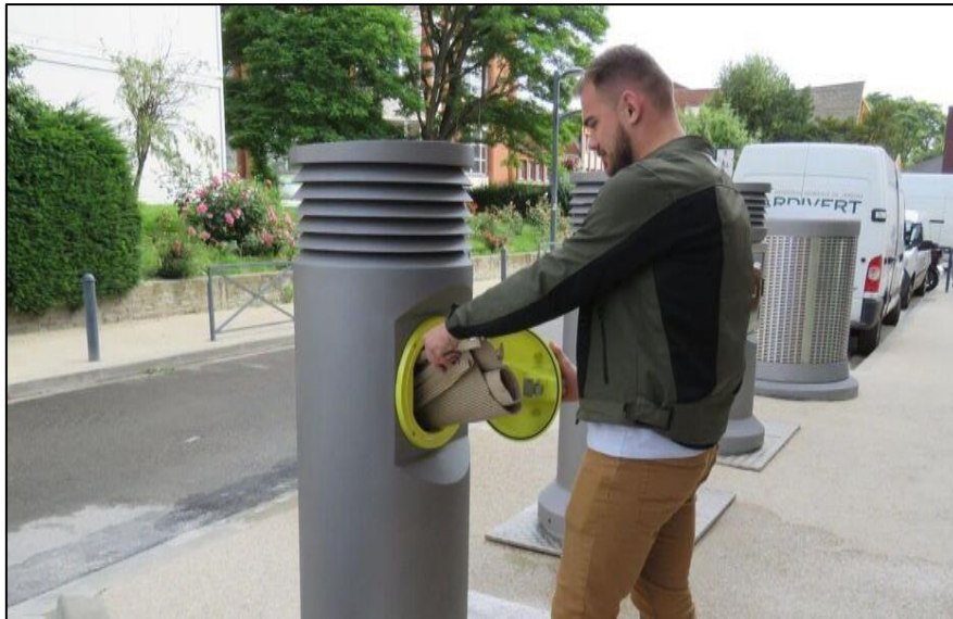
Figure II.1: Collecte pneumatique des déchets [13].
