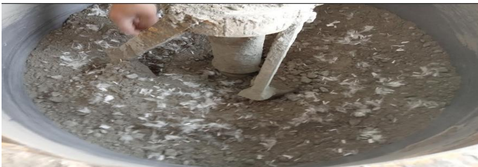
Figure 21 malaxage béton avec les fibres PP
