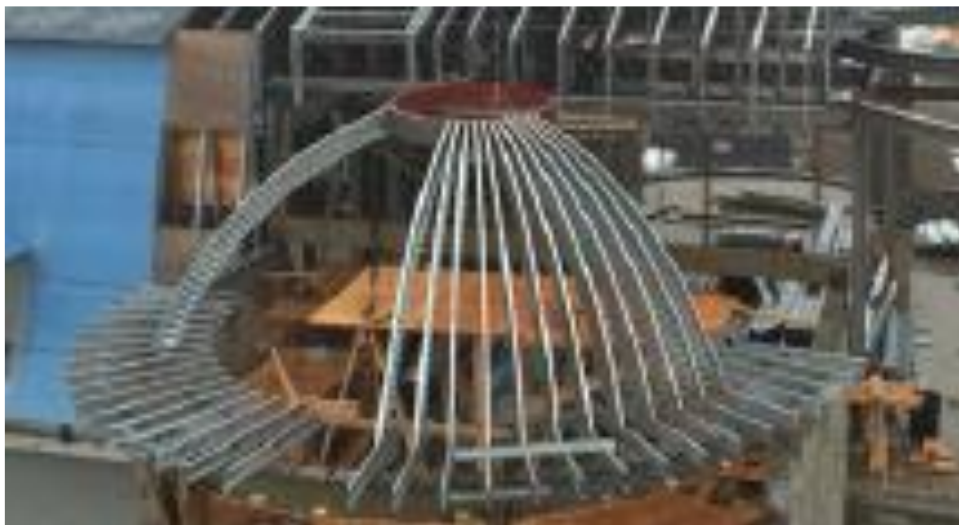
Figure 2.2 : Coupoles à nervures méridiennes.
