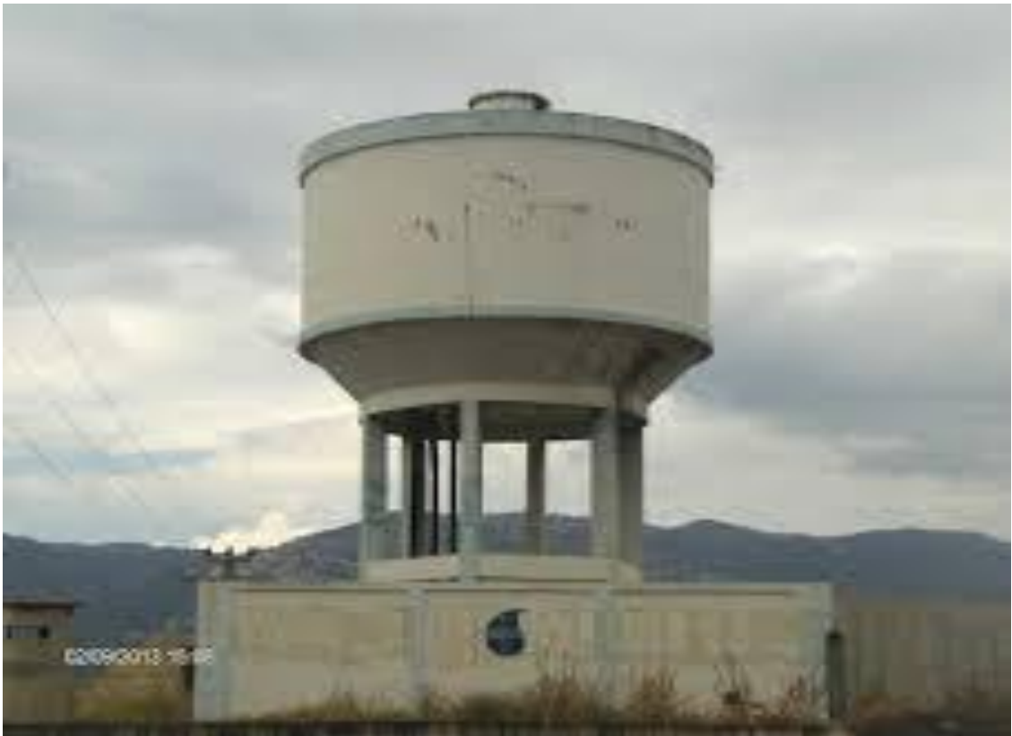
Fig. I.2 .Vue générale du réservoir sis à Sheikh Oumedour. [9]
