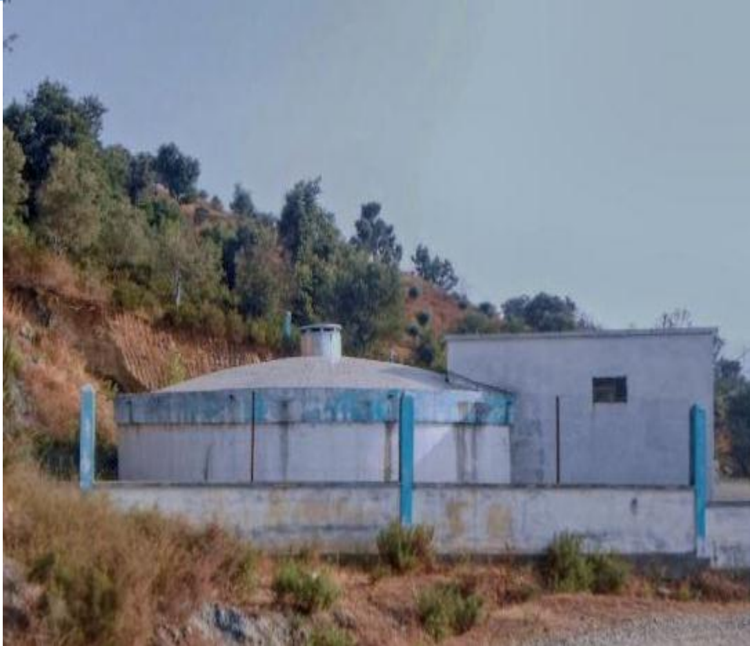
Fig. I.3. Réservoir circulaire posé au sol en béton armé [9]
