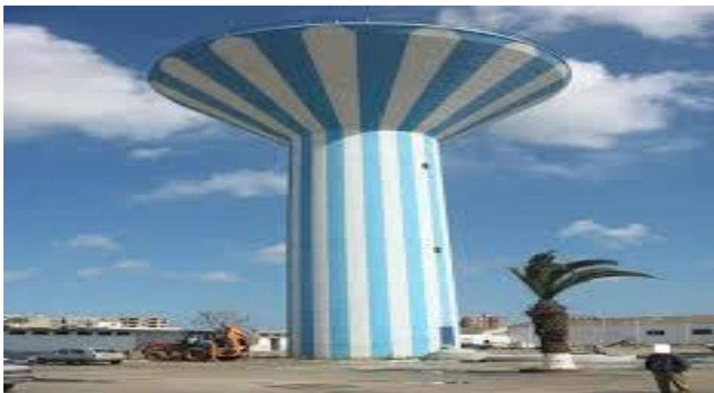
Fig. I.1. Réservoir surélevé de 1500 m 3 (BOUMERDES). [9]
