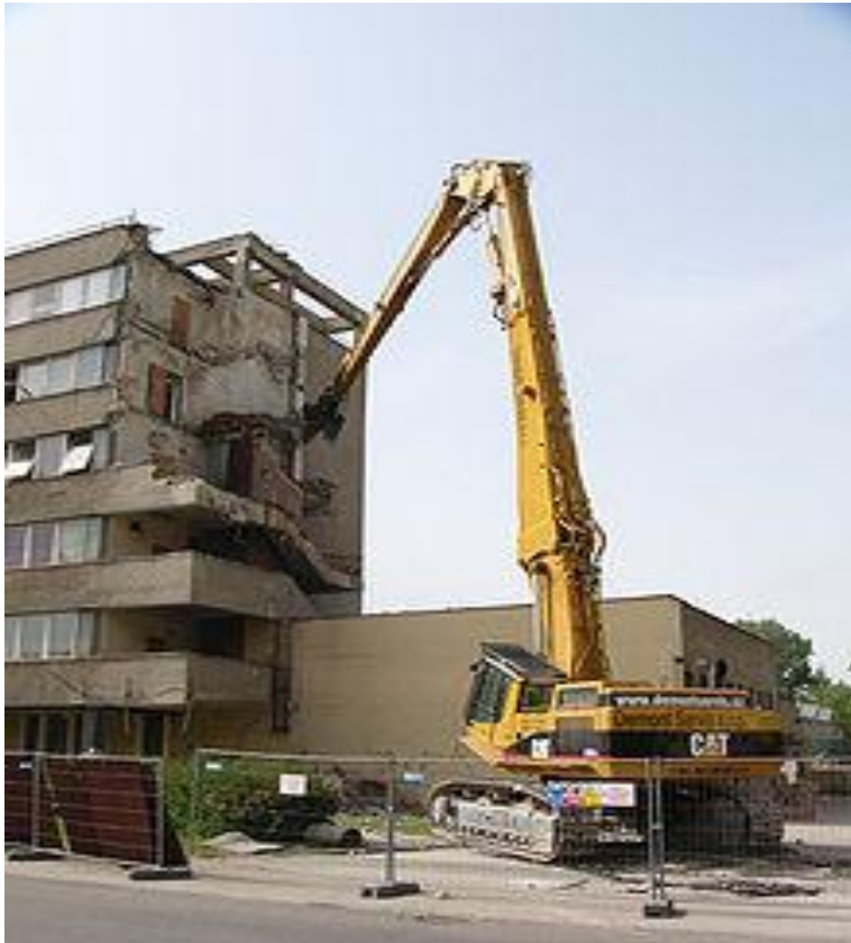
Figure 2.1. démolition d'un ouvrage.
