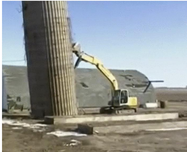
Figure 2.8. Démolition à la pelle.
