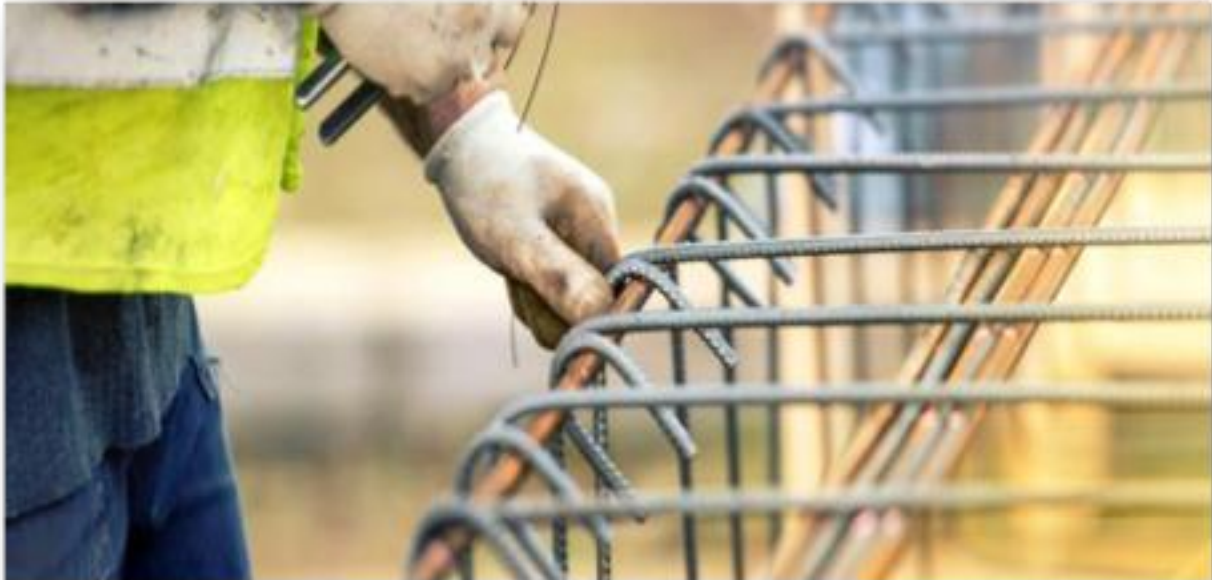
Figure 6.1. Façonnage des aciers.
