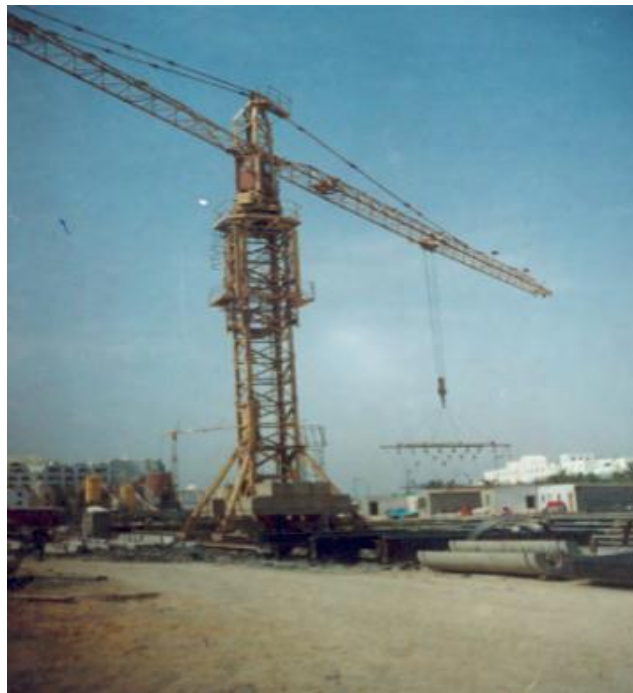
Figure 4.2. Emplacement des grues.
