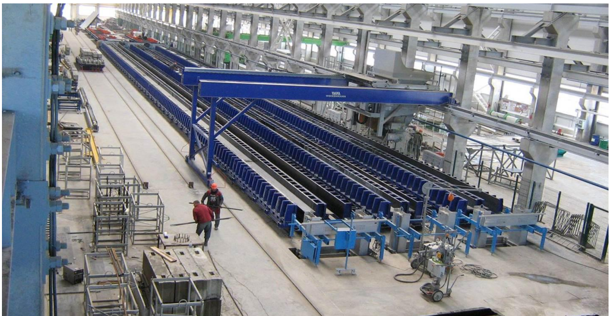
Figure 4.4. usine de préfabrication
