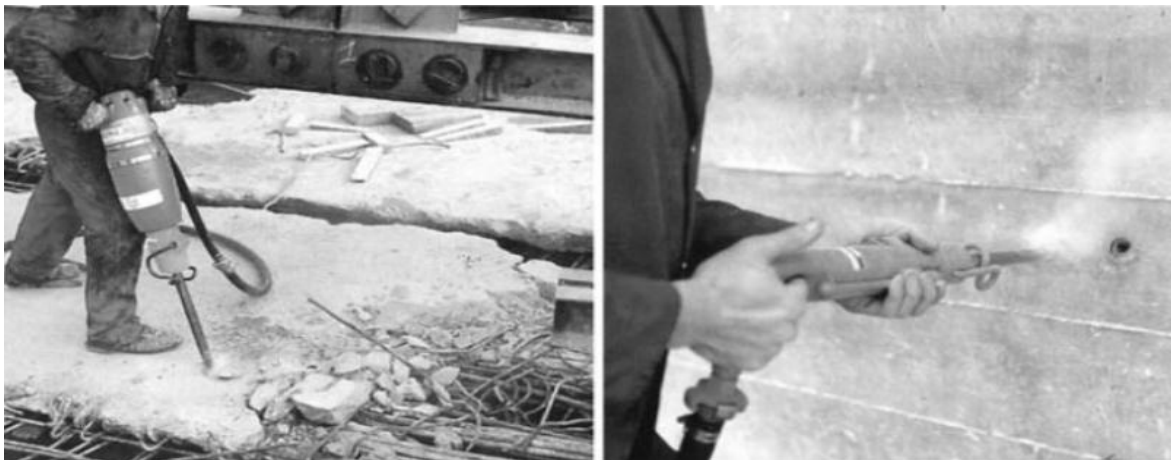
Figure 2.2. Marteaux piqueurs et marteaux foreurs.
