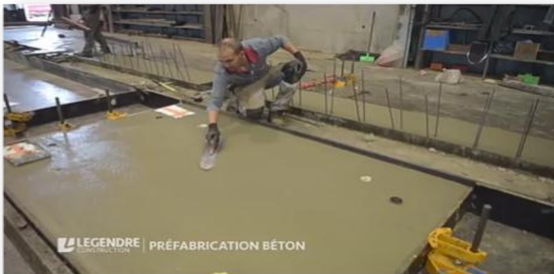
Figure 6.5. Coulage et lissage des panneaux.
