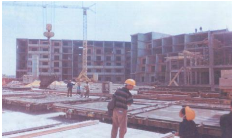
Figure 4.1. Atelier précaire à l'air libre au pied de l'ouvrage à édifier.
