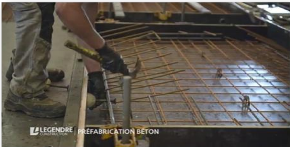
Figure 6.4. Disposition de l'armature dans le moule.
