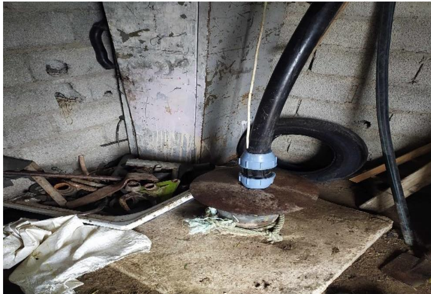
Figure 05. Forage de la ferme Bergé.
