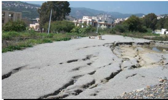
**Fig1. 1 : Fissures, tassements sur la plateforme du stade à Bejaia**
