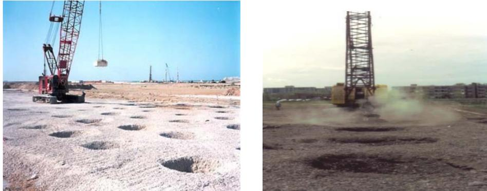
**Fig3. 2 : Exemple de chantiers de compactage dynamique**
