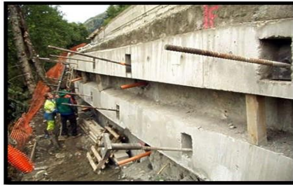
Figure II.37: Exemple de tirants d'ancrage actif
