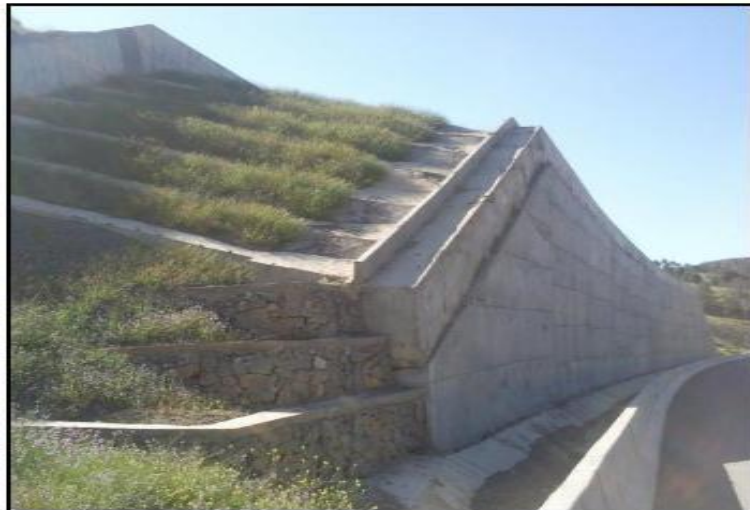
Figure II.35: Exemple d'ouvrage souple (Achoui et Dahmani ,2013)
