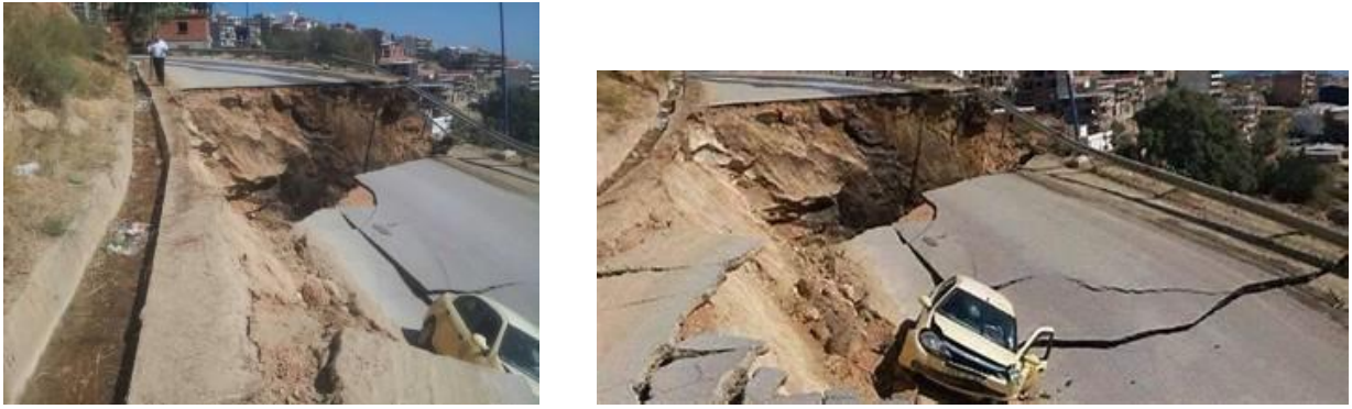
Figure II.24: Glissement dans le quartier de Sidi Aissa sur la bretelle Kouba à Ain Achir
