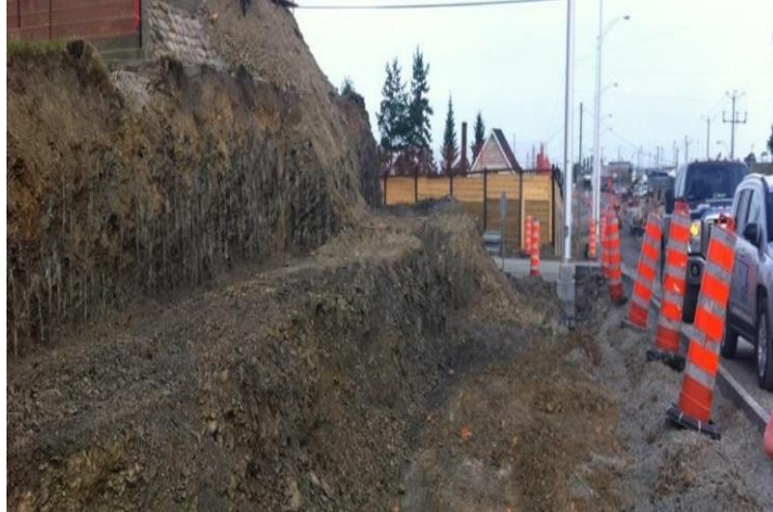
Figure II.15: Les déblais ou les excavations à la base du talus (Rhône, France). (H, Zakaria et D, Mohamed., 2019)
