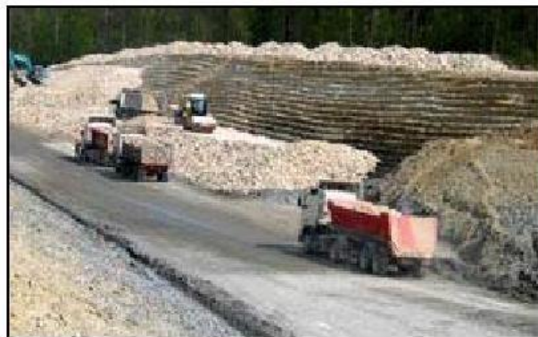
Figure II.34: Réalisation du masque drainant (Achoui et Dahmani ,2013)
