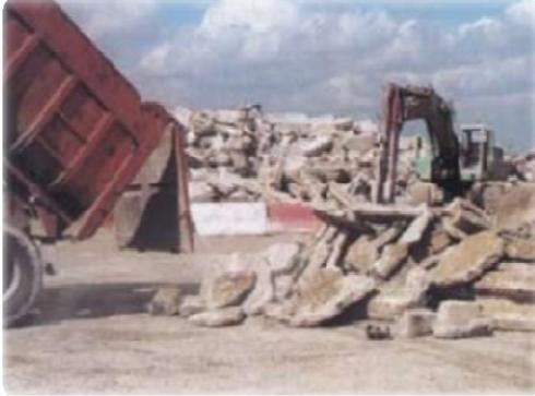
**Figure II.5 :** Réception des bétons de démolition.
