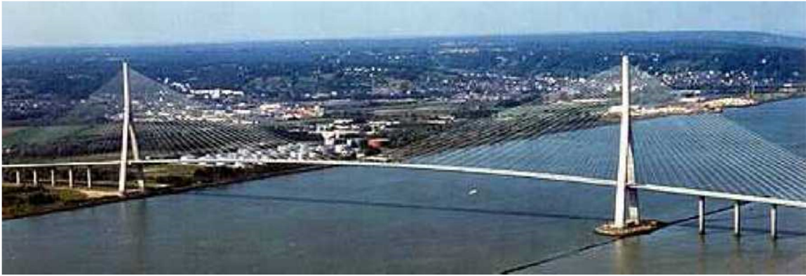
Figure 1.1.1: Pont de Normandie avec 856 mètres de travée centrale.
