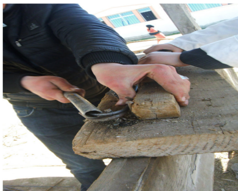
Figure 2.III.2 : Façonnage des aciers.
