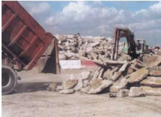
Figure III.2 : Réception des bétons de démolition
