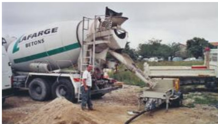
Figure I.1 : Camion toupie alimentant une pompe à béton
