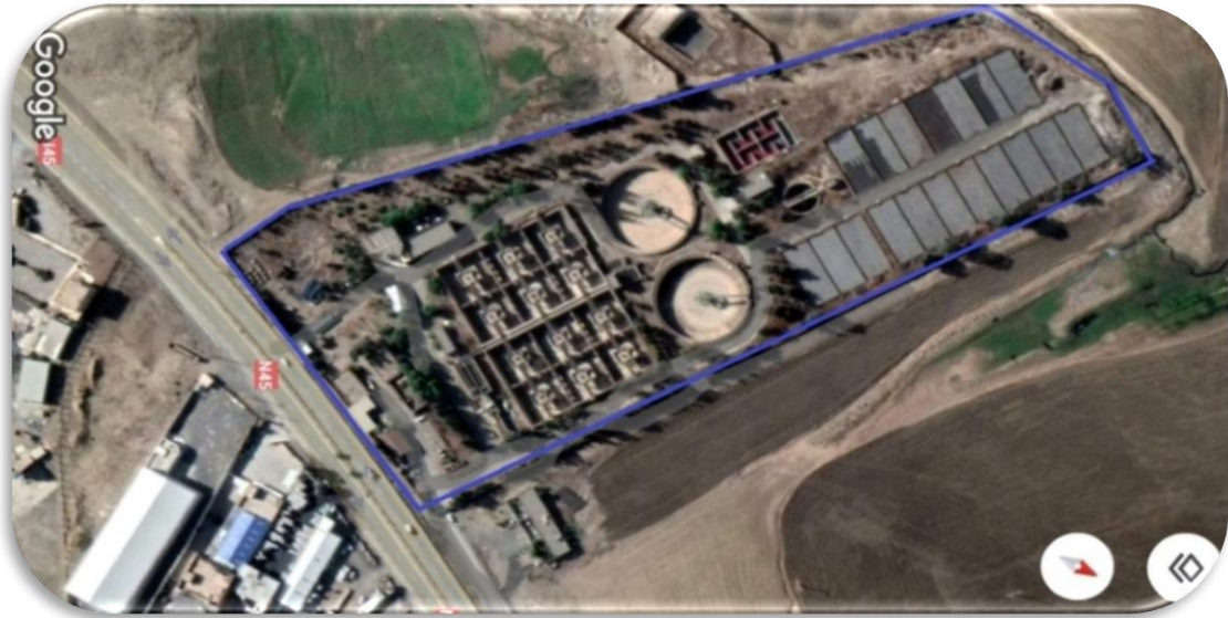
Figure 17: Photo par satellite de la STEP de BBA.
