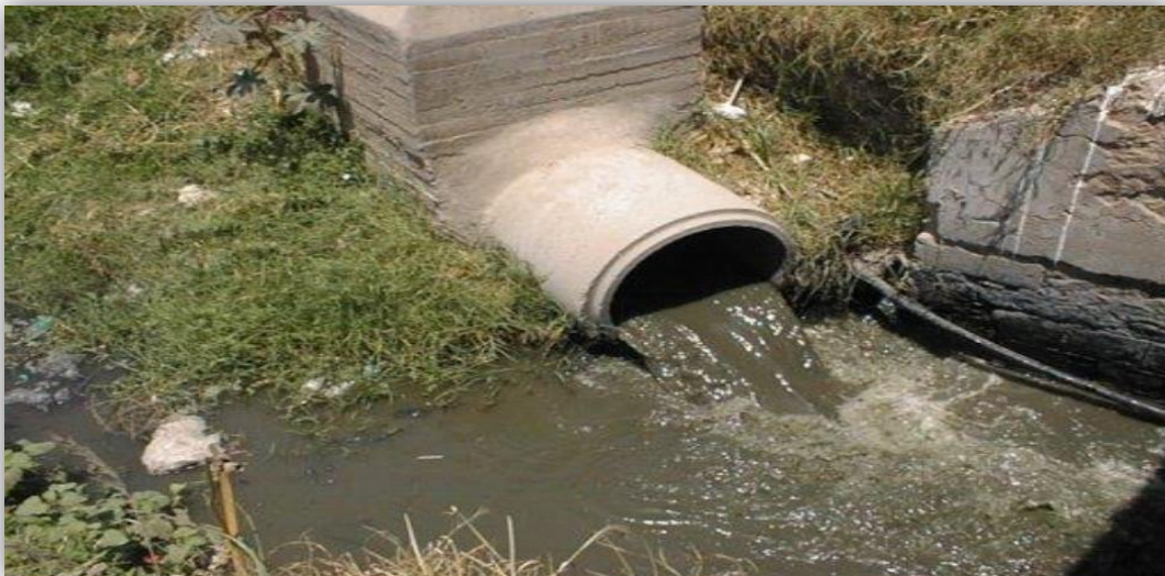
Figure 02 : Point de rejet d'eaux usées [7].
