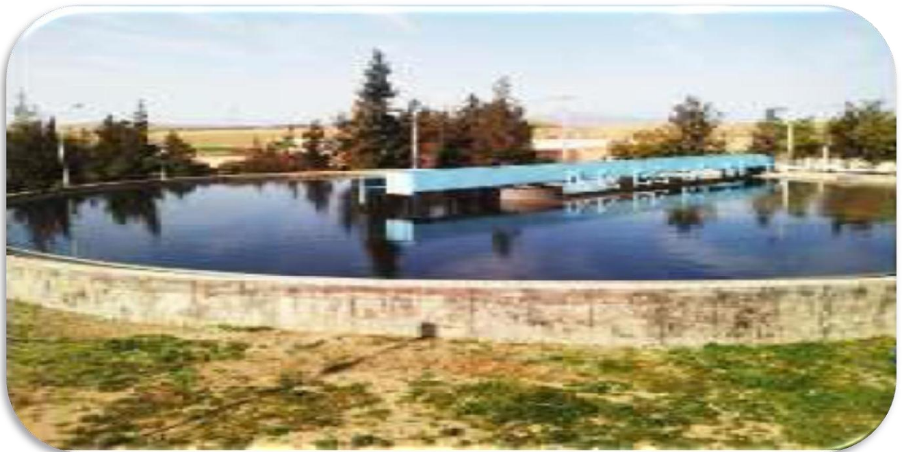
Figure 13: Décanteur secondaire (STEP BBA)
